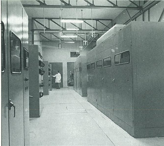
A la derecha, parte trasera de los armarios que contienen los dos emisores gemelos de 125 kW. Suspendidas del techo aparecen las canalizaciones coaxiales de RF. A la izquierda, diversos cuadros de automatismos.
