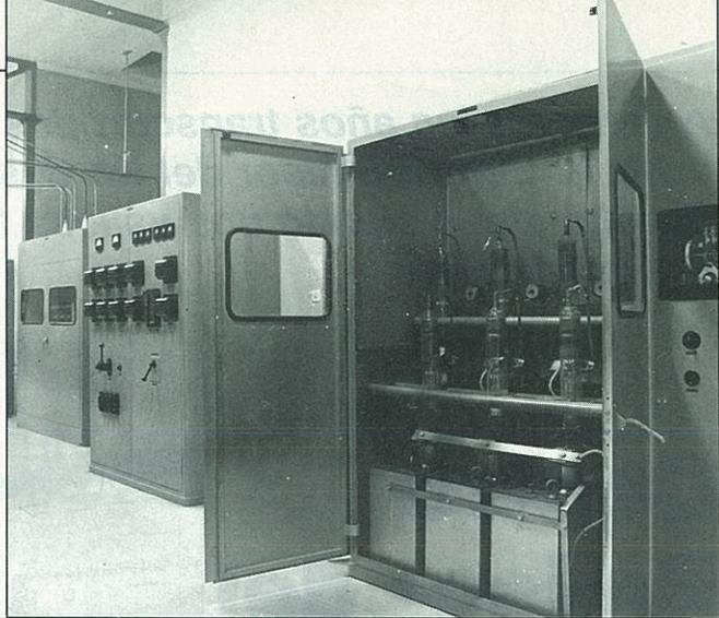
*Estación rectificadora en hexafásico de tiratrones de vapor de mercurio. A la izquierda, armario de automatismos gobernado por el pupitre de control. Al fondo, la unidad de puesta en paralelo de los dos emisores. La línea coaxial suspendida del techo canaliza la RF hacia el alimentador.*
