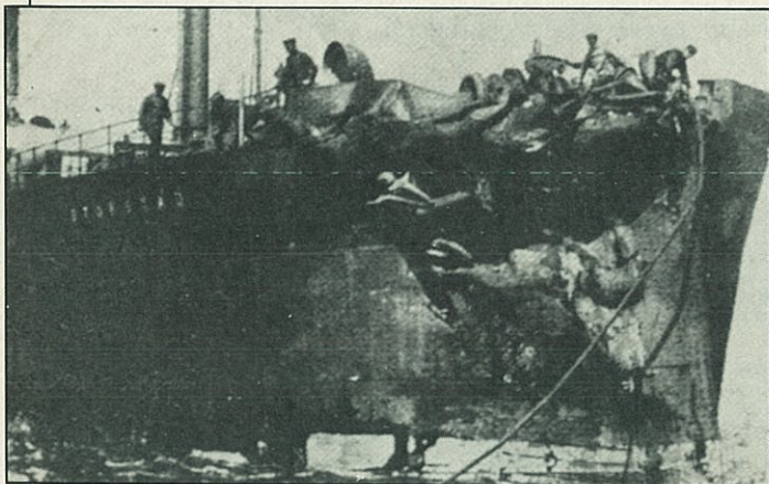
Figura 10. Proa del buque carbonero noruego Storstad tras su colisión con el buque de pasaje Empress of Ireland (1914).
