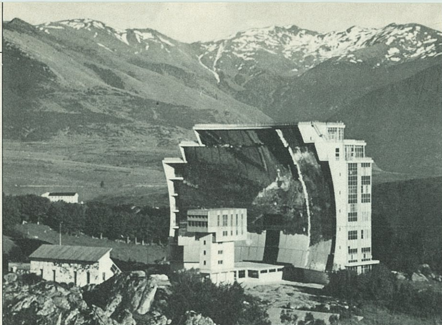
Central-horno solar de Font Romeu (Pirineos Orientales) situada a 1.800 m de altitud que produce 1.000 kW y una temperatura del horno de 4.000° C, con su espejo parabólico de 54 m. Pertenece al Centre National de Recherche Scientifique (Francia).
