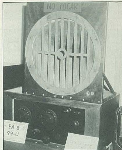
Receptor de radiofrecuencia sintonizada, sin conversiones. Sintonía por acoplamiento directo entre bobinas Tesla con mando micrométrico. Altavoz por imán de herradura. (EA8AHC.)
