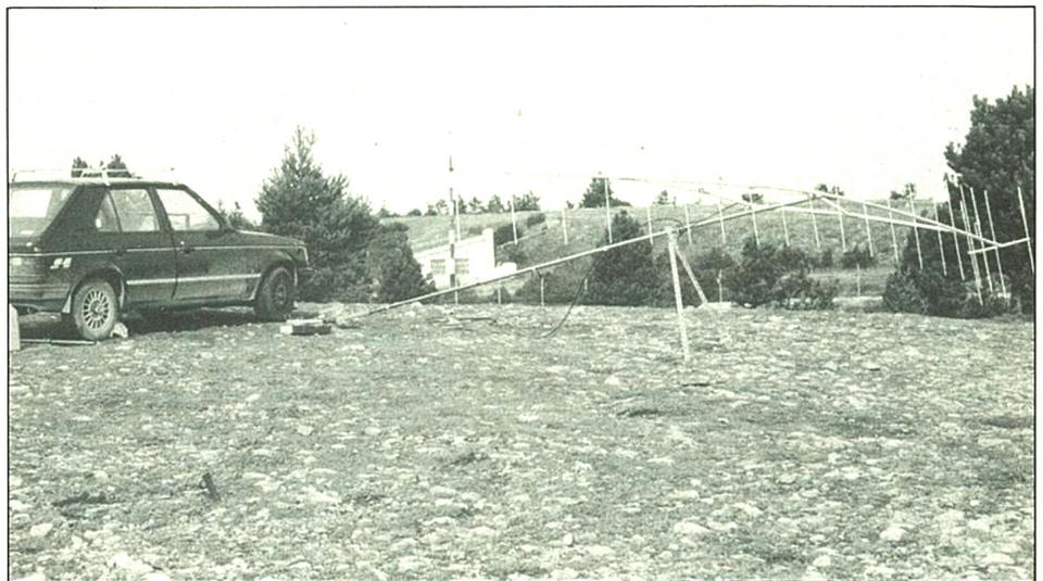
Foto 5. Mástil abatido, con la antena ya colocada y dispuesta a ser izada.
