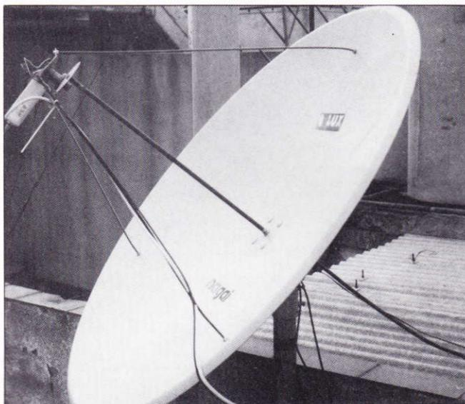
Antena para recepción del Meteosat.
