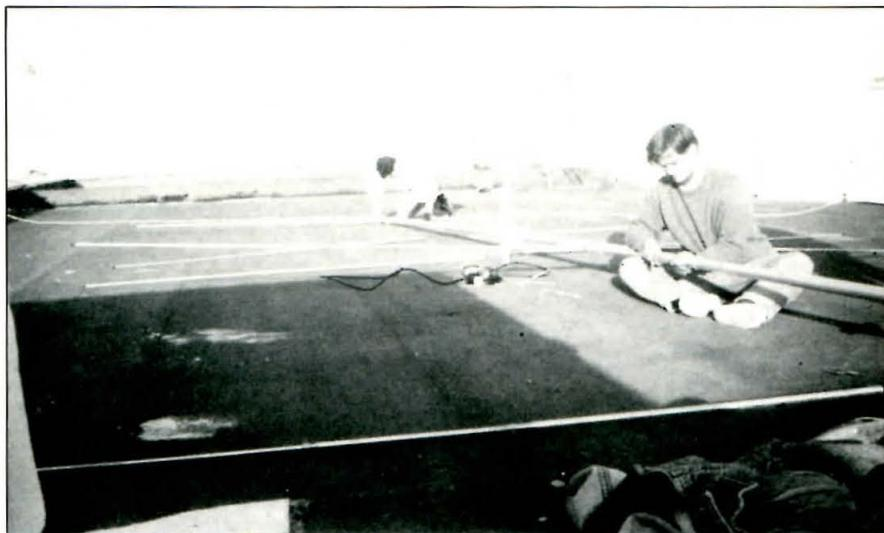
EA1AK y EA4BB montando la antena de 28 MHz (5 elementos).
