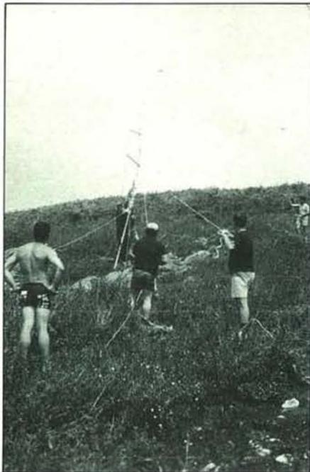
Instalando la G5RV, que iba a dar un gran resultado en 40 y 80 metros. En lo alto del mástil de 10 metros de alto se instaló una 5/8 para 144 MHz.
