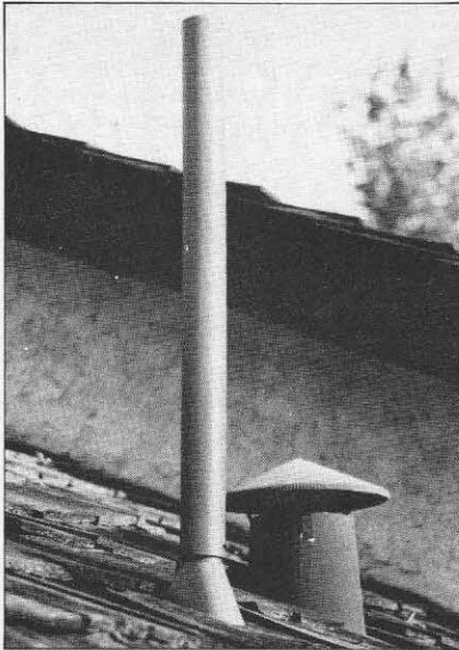
tubo de respiradero que exista en el tejado, con lo que simplemente se convierte ella misma en la apariencia de un tubo de ventilación, en el colmo de la disimulación o camuflaje... Sugiere el fabricante que siempre se podrá instalar una base en forma de tubo de ventilación falso sobre el que montar la antena a prueba de vecinos o propietarios restrictivos en cuanto a las antenas de radio.
