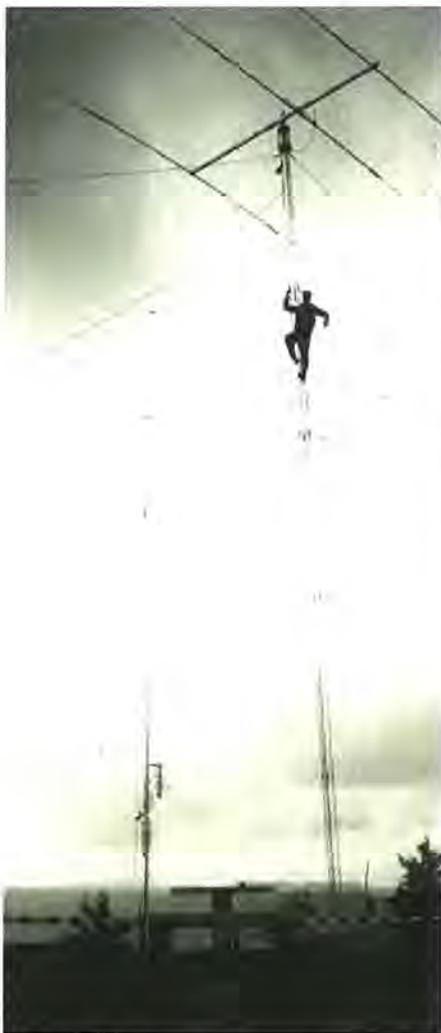
Sistema de antenas montado expresamente para el concurso CQ WW de 1991: 3 tres elementos Yagi, dipolos y Butternut de EA2CGA.
