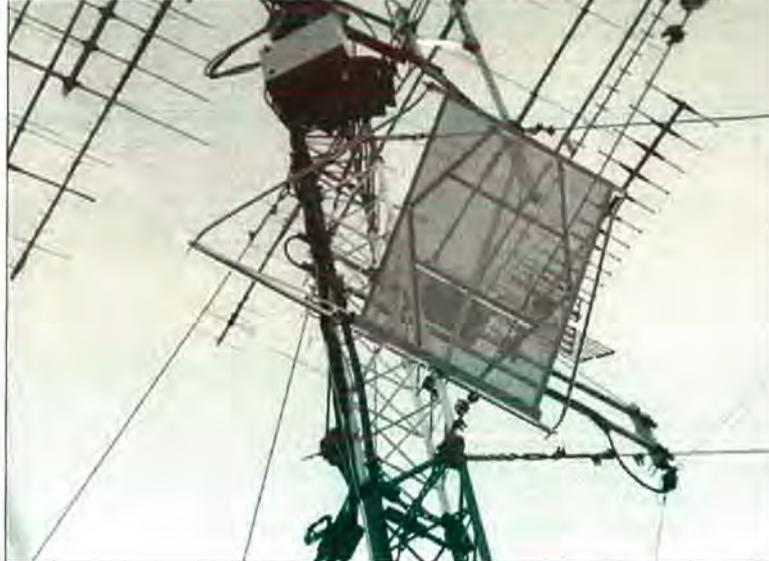
**L**a antena de *periscopio*, muy a pesar de su denominación, no es exactamente una antena, sino un reflector de señales de radio, utilizado como parte de un sistema de comunicaciones. Su utilización se justifica en casos en que es muy difícil instalar sistemas electrónicos para repetir las señales en enlaces de microondas, especialmente en zonas montañosas de difícil acceso y siempre que sea necesario franquear obstáculos, incluso con dobles reflexiones (figura 1).
