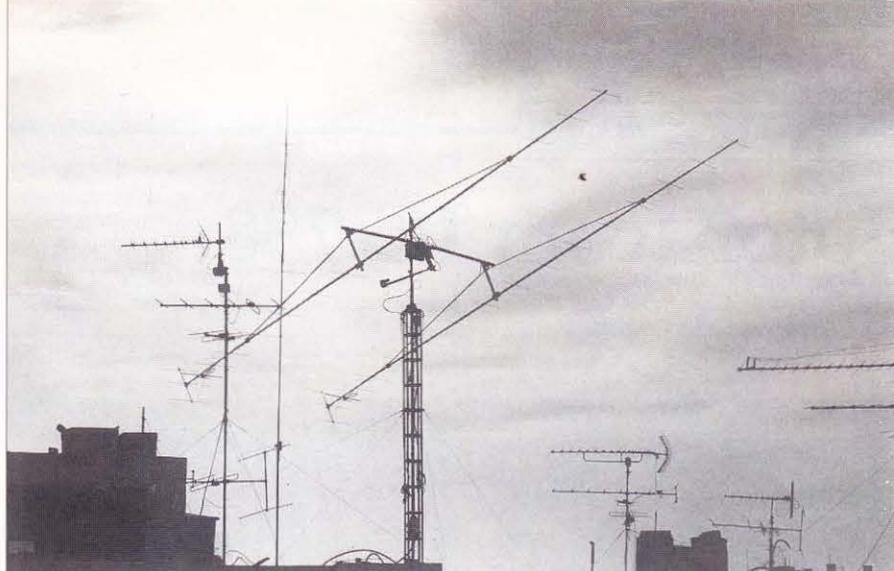
Antenas para rebote lunar de 9H1BN: dos Yagi 4218 de Crushcraft.
