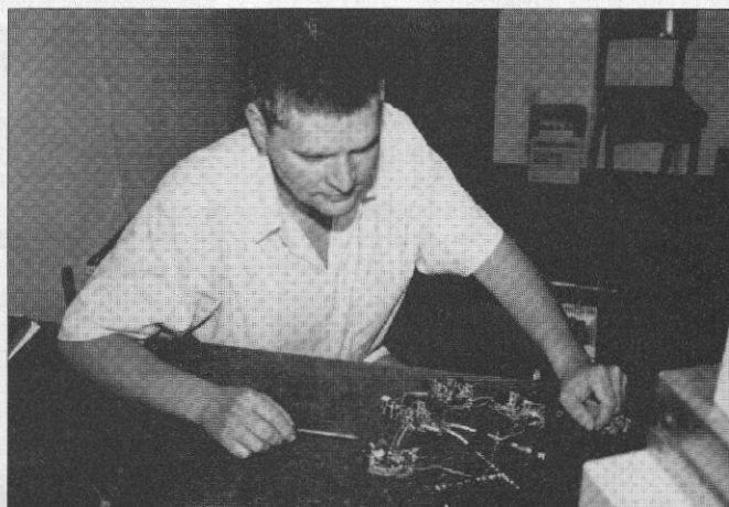
Aquí se ve a Mathias Vidmar, S53MV, en su taller de Eslovenia, experimentando con prototipos del circuito LEILA destinado al satélite Phase 3D . El circuito está diseñado para añadir un mensaje al enlace descendente que alerte a los operadores de las estaciones terrestres que usen inadvertidamente demasiada potencia en el enlace ascendente.
