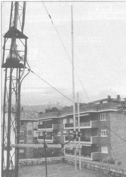
Antena «J» colineal, montada en la parte inferior de la torreta.
