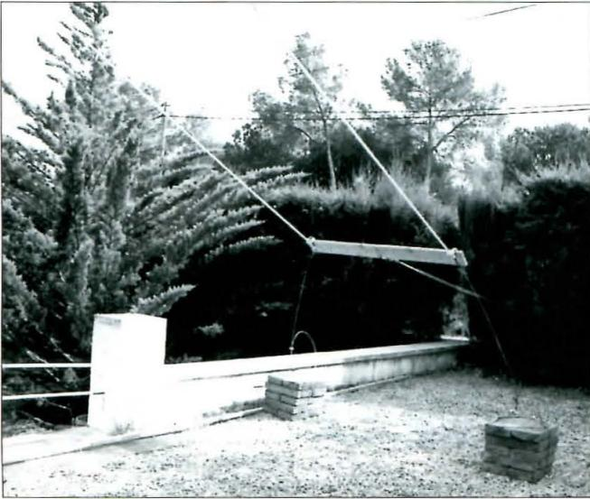
Foto 2. Dispositivo de anclaje del tobogán. Un cable de acero (poco visible en esta instantánea) tensa el conjunto hacia atrás.
