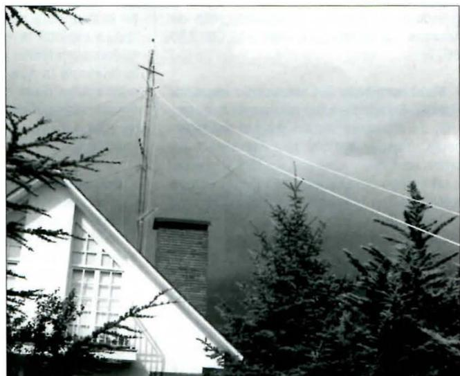
Foto 1. La «cama de cuerdas» extendida entre el travesaño de la puntera de la torreta y el suelo del jardín.
