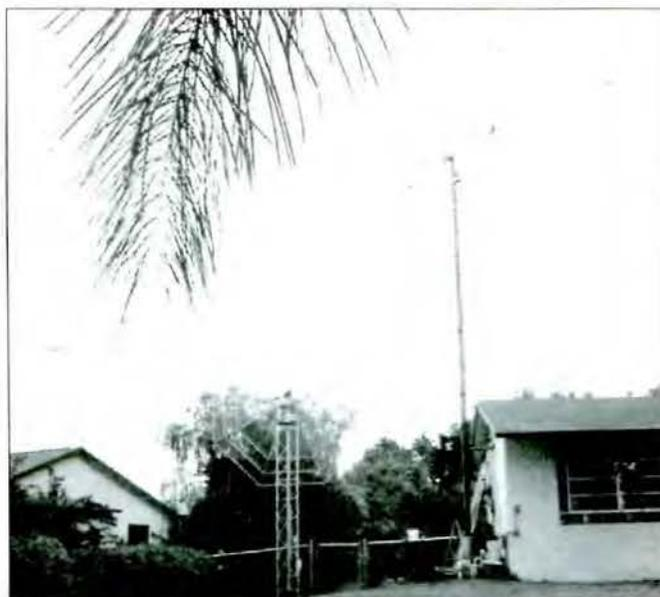
Antenas para RL 144 y 1296 MHz de K9BCT, 4 x 14 el. 3,4 λ y parábola de 3,7 m de diámetro.
