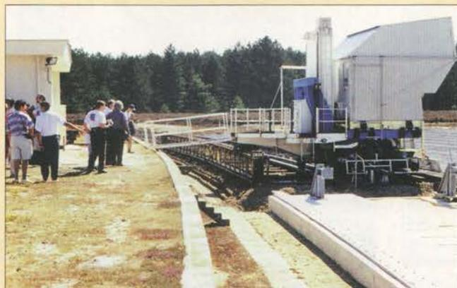
La caseta de receptores del radiotelescopio decimétrico se desliza sobre raíles para compensar el giro de la Tierra.
