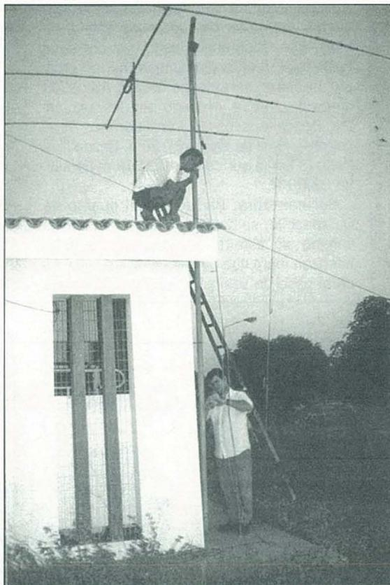
Instalación de un dipolo para 6 m entre D2BF y D2BB.
