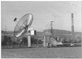
Panorámica de antenas para RL de HB9Q, destaca la enorme parábola para 1.296 y 432 MHz de 15 m de diámetro y la formación de 8 x 19 elementos para 144 MHz.
