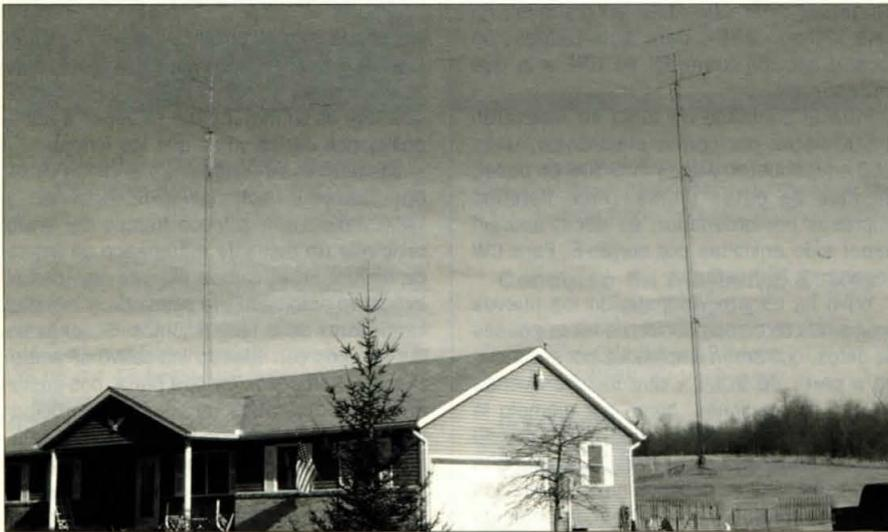
Antenas de N8BJQ. La torre de la izquierda sostiene monobandas para 2, 6, 10 y 15 metros; en la de la derecha hay tres tribandas enfasables y una dos elementos para 40 metros.
