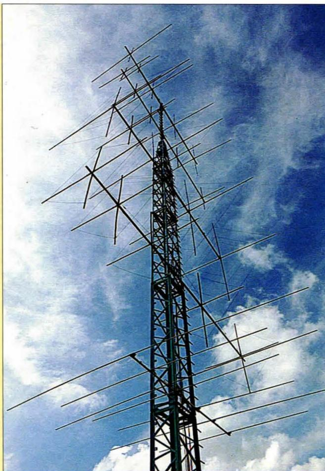
Una torre giratoria de SP7GIQ, con cúbricas apiladas y una modesta Yagi para las bandas WARC en la parte inferior.
