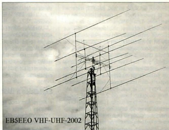
Impresionante formación de antenas para 144 y 432 MHz de EB5EEO.
