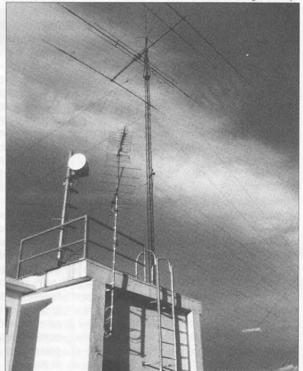
*La antena debería estar por detrás y más alta que la de televisión del edificio*
