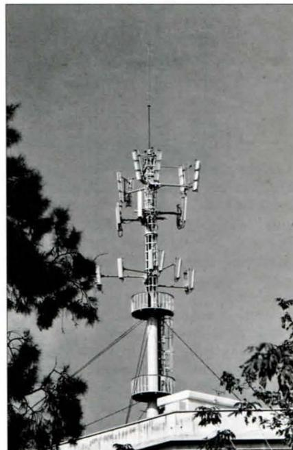
Foto A. Instalación de antenas de telefonía móvil en un entorno ciudadano, con tres órdenes de antenas sectoriales y una antena omnidireccional. El bloque de antenas direccionales está situado a una altura superior a la de los edificios de viviendas colindantes. (Telefónica Móviles, Barcelona).
