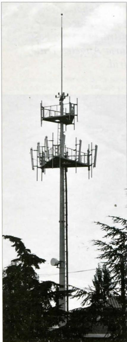
Foto B. Torre de antenas de TM en un entorno mixto agrario y residencial extensivo. En la parte superior está instalada una antena omnidireccional, mientras las antenas sectoriales lo están a media altura. (Ametlla del Vallés - Barcelona).
