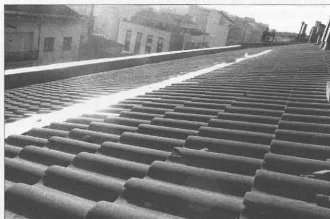
Figura 4. Un «radial» de papel de aluminio extendido sobre la cubierta de teja cerámica puede hacer el papel de contraantena.
