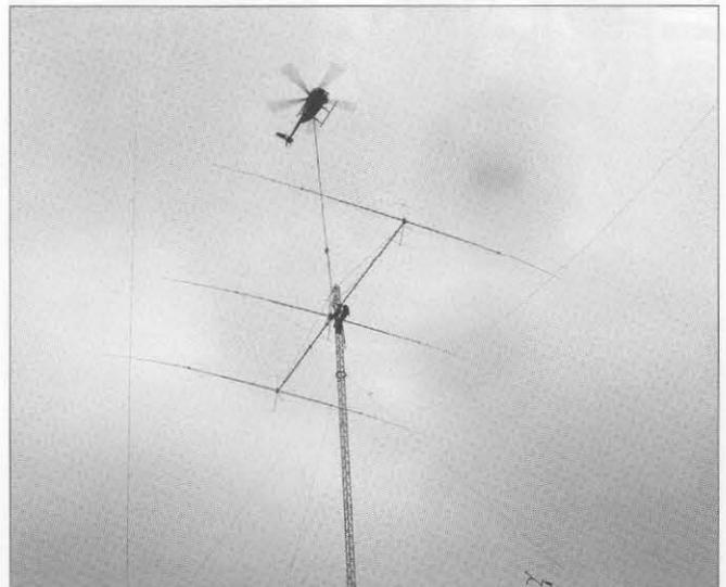
La Yagi para 80 metros fue levantada hasta lo alto de la torre por un helicóptero. El trabajo se hizo bajo una fuerte lluvia, ¡pero aún así sólo se tardaron 20 minutos!
