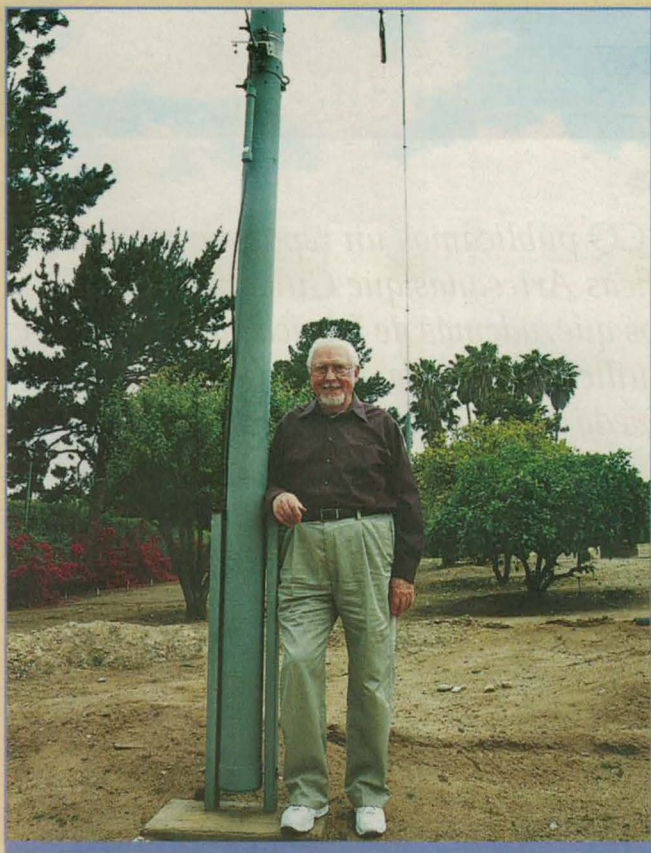
Esta es la base de una de las verticales enfasadas que Ed, W6KUT, utiliza actualmente para operar en 160 metros. A nuevos tiempos, nuevas metas.
