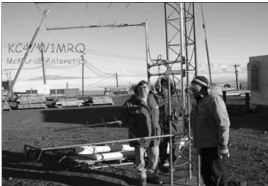
La antena de 4x5 elementos de KC4/W1MRQ (Antártida) para RL en 144 MHz.
