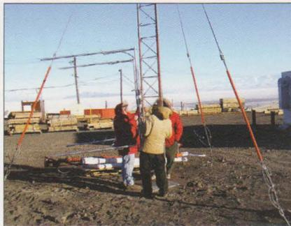
*El autor y otro empleado de Raytheon Polar Services montando el conjunto de antenas para RL en la torre de radioaficionados existente en la base McMurdo.*
