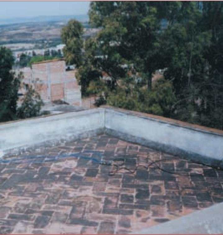
Nueve metros de alambre de cobre de 0,25 mm de diámetro están instalados en el techo de mi apartamento en México. Menos unos 60 cm, está totalmente pintado. ¿Puede usted apreciar el hilo? La foto está tomada a unos 4,5 m lejos del hilo.
