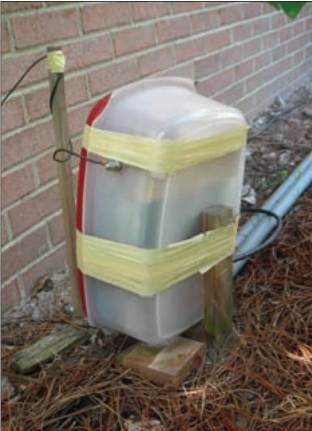
Foto 4. Este es el punto de alimentación de la antena de K8CQ a la que llama "antena de canalón". La línea de transmisión desde la estación se conecta a un sintonizador SGC-237 dentro de una caja de plástico. El cable de salida del sintonizador se conecta a la base de la antena. Dado que la antena es baja y cercana a la zona habitada, Jeff nunca utiliza más de 100 vatios de salida (Foto cedida por K8CQ).
