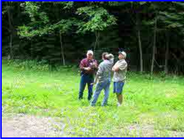
Putting up antennas.
