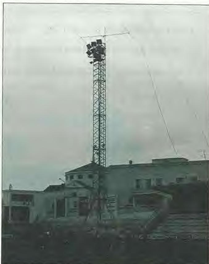
*Cualquier lugar alto y despejado puede ser bueno para la instalación de antenas. Observad que es una de las torres para la iluminación del Estadio de Fútbol de Ceuta durante una multioperación. A la derecha, la bajada de los dipolos.*
