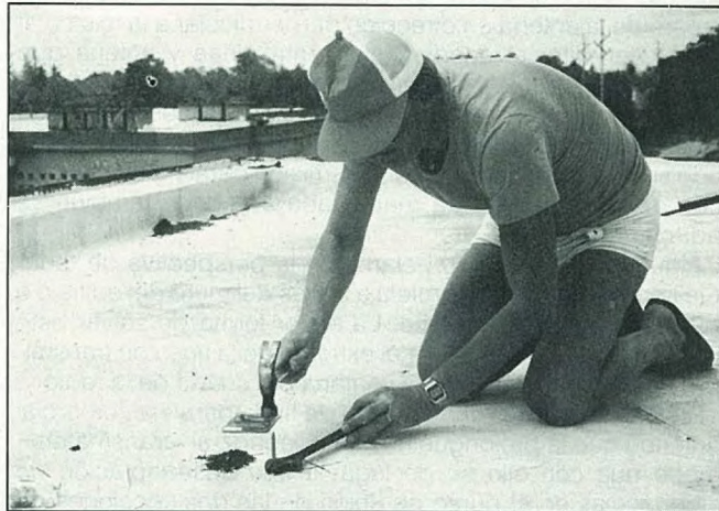
Leif, SM0AJU, haciendo agujeros que sirvieran para el anclaje de los vientos.
