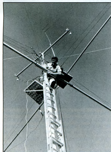
¡Trabajo difícil el de Jerry, NC7U, para amarrar al travesaño los vientos laterales de seguridad!
