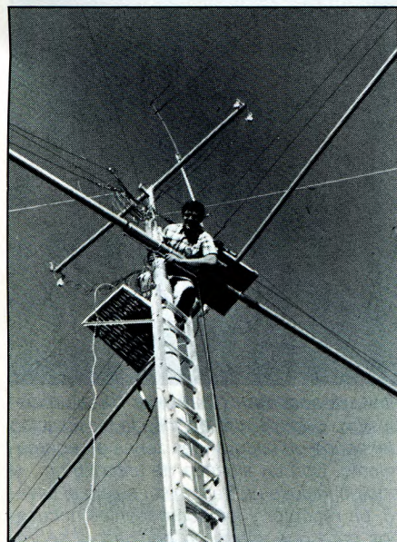
¡Trabajo difícil el de Jerry, NC7U, para amarrar al travesaño los vientos laterales de seguridad!
