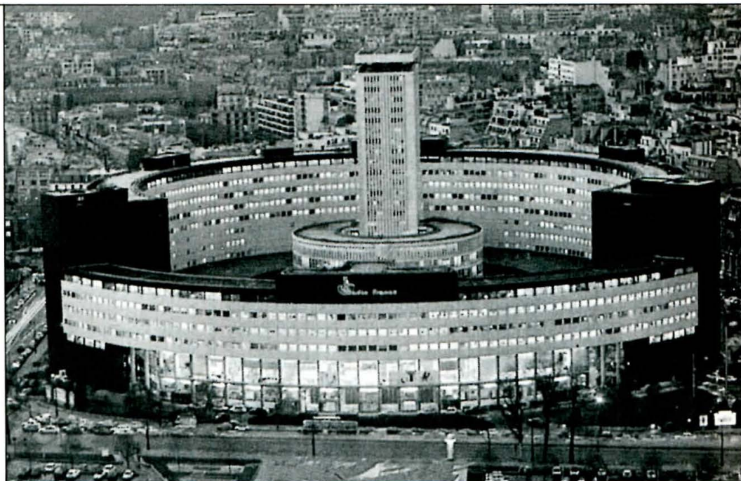
El edificio circular de la Sociedad Francesa de Radiodifusión, Radio Francia Internacional, especialmente diseñado para aislarse del ruido.
