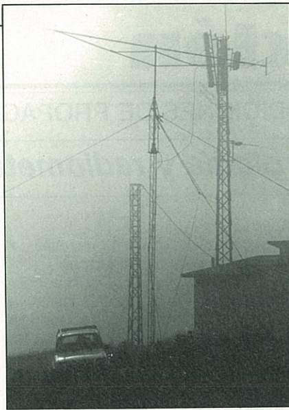
La antena de 21 elementos a 9 metros de altura soportó muy bien una noche de viento y lluvia. El domingo, aunque ya no llovía, seguimos metidos en la niebla. (Foto de EA3FER).
