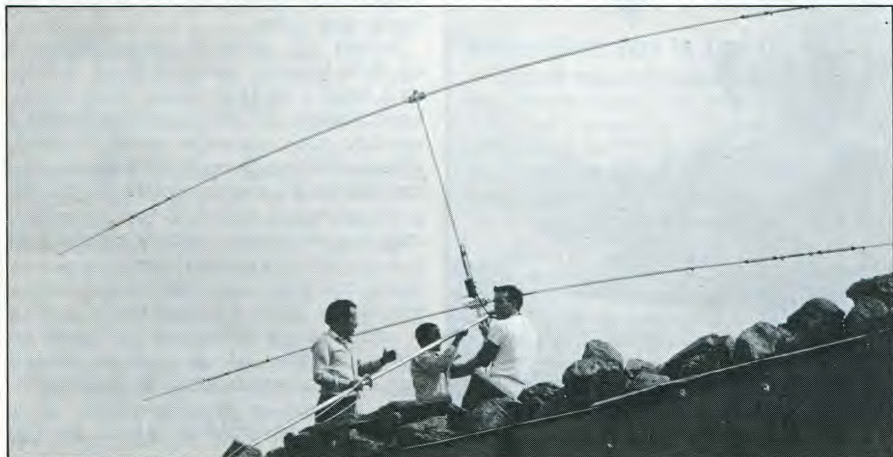
Momento de la colocación de la antena en el tejado.
