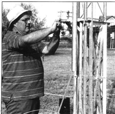
Figura 9. NØJW monta el cojinete de paso opcional en la Hazer. Este cojinete facilita notablemente el buen funcionamiento del sistema.
