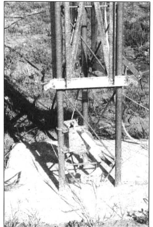
Figura 5. Montaje del cabrestante al pie de la torreta, en el punto más bajo posible para permitir que la antena pueda descender casi a nivel del suelo.
