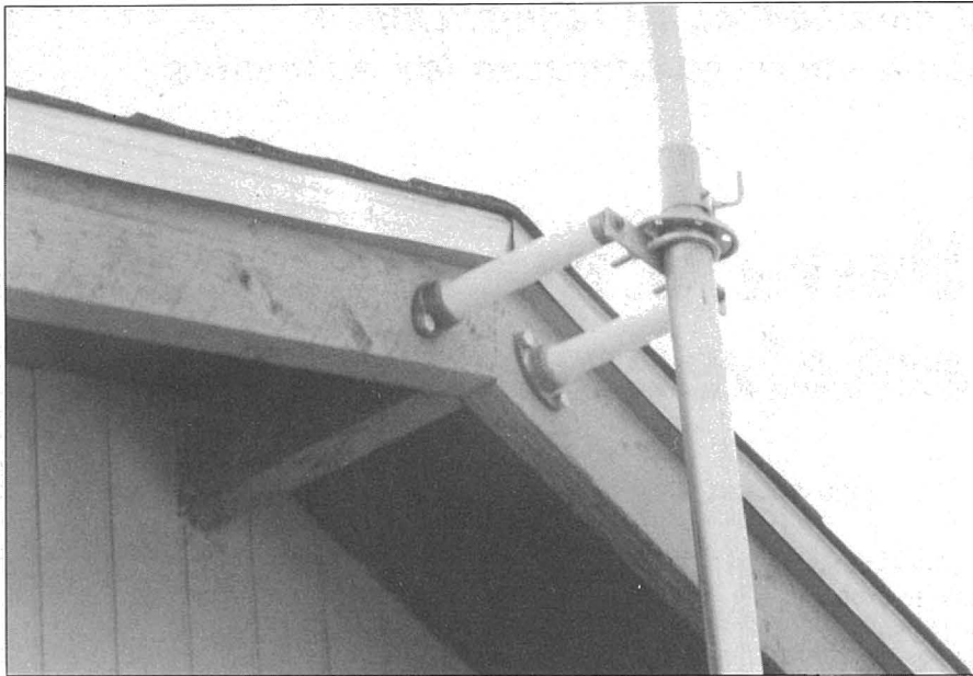
Los aisladores separadores permiten un montaje idóneo y limpio para la sujeción de la antena a los pares del tejado.
