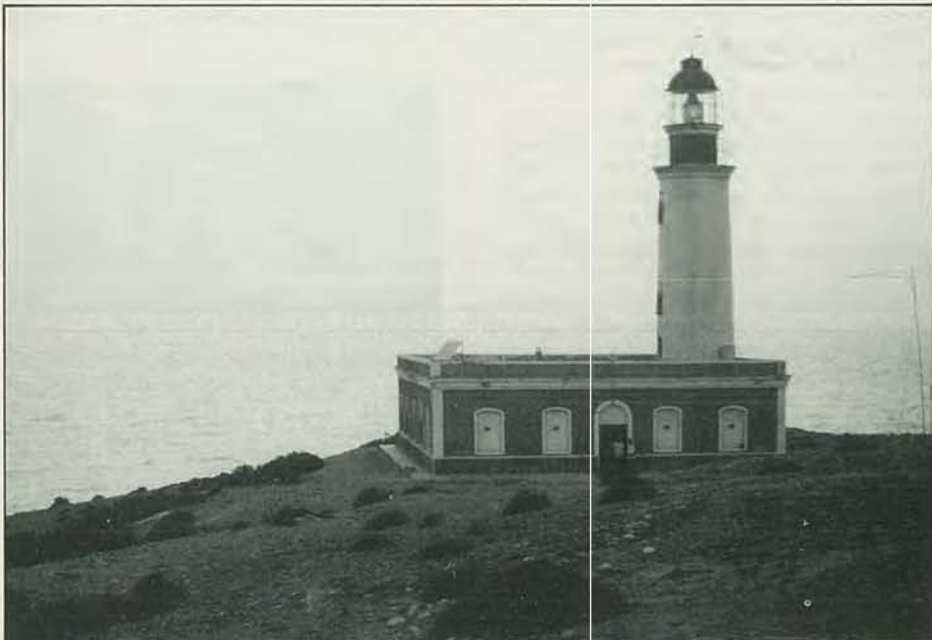
Vista del faro.
