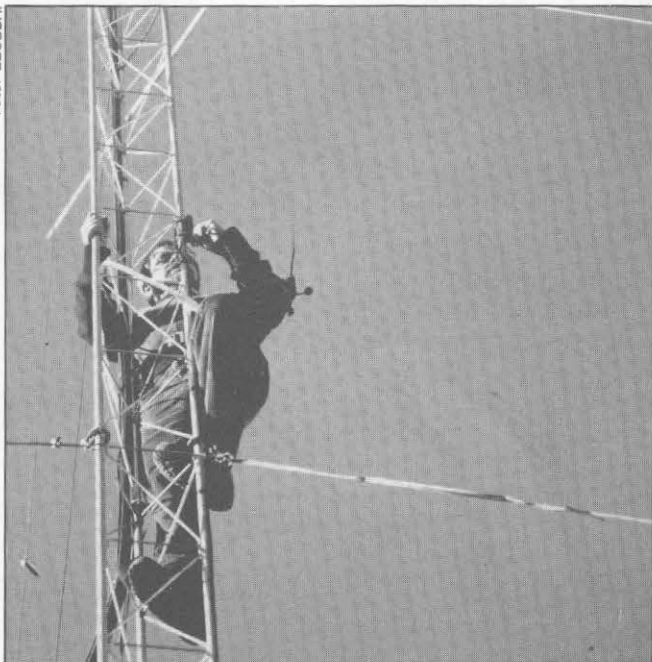
Joan, EA3AAB, montando los sensores de velocidad y dirección del viento en la torreta de las antenas.
