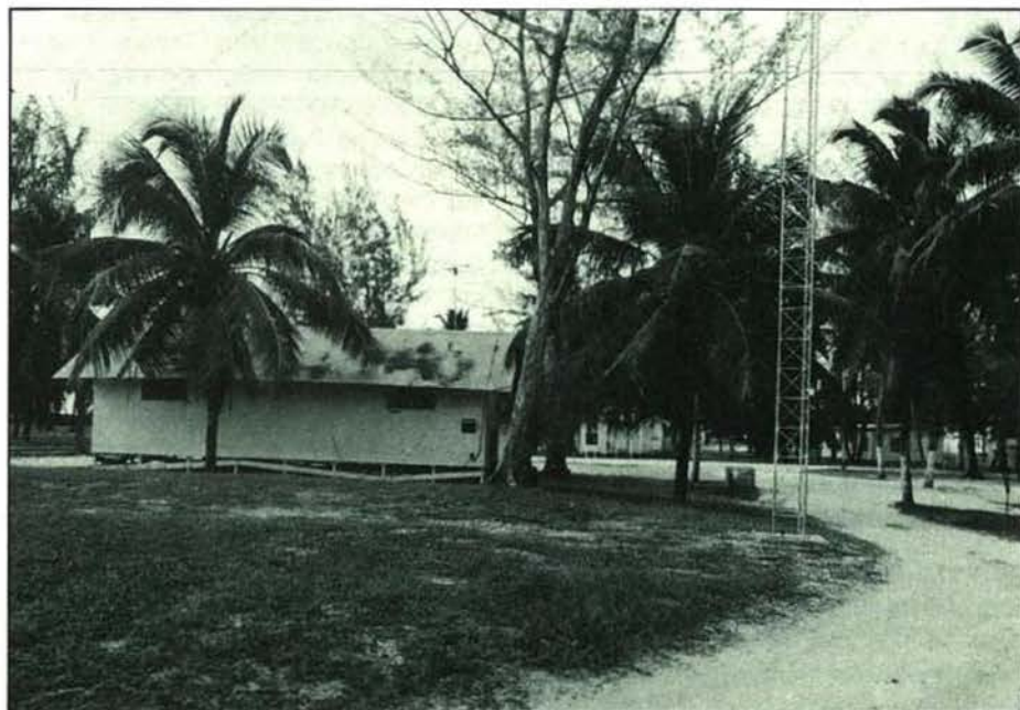
Estación de radioaficionado de la isla Diego García. Junto al barracón, una torreta de 30 m de altura coronada con una antena TH7DXX.
