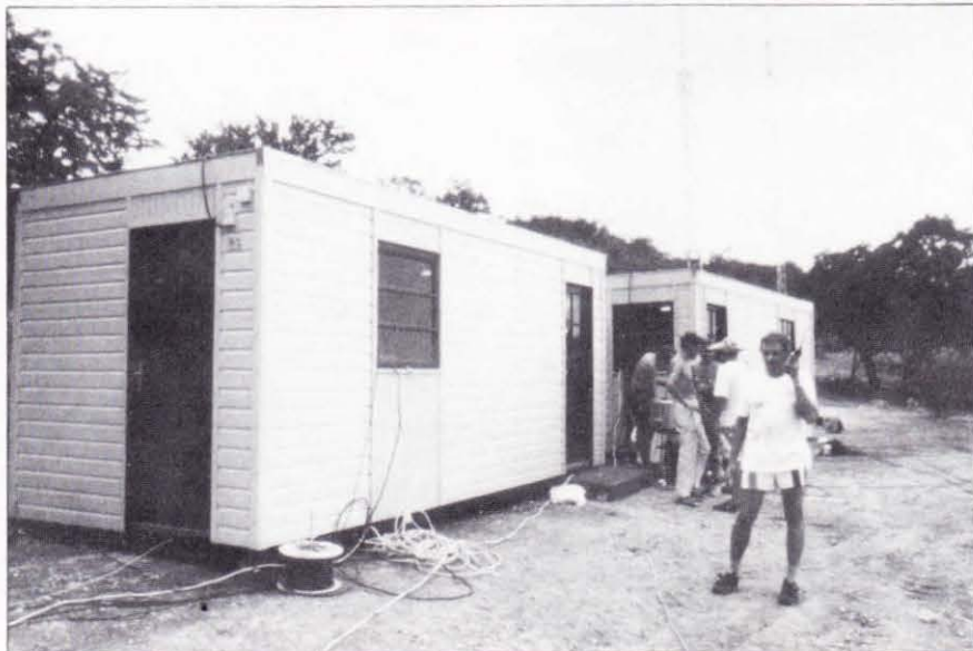
Los módulos construidos especialmente para albergar los puestos de operación.
