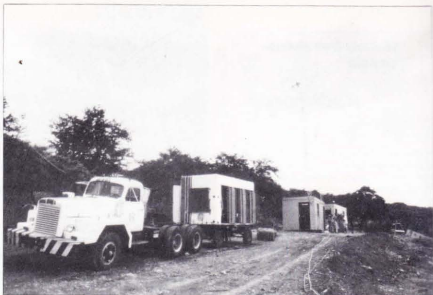
El generador de 300 kW en el transporte al puesto de operación.
