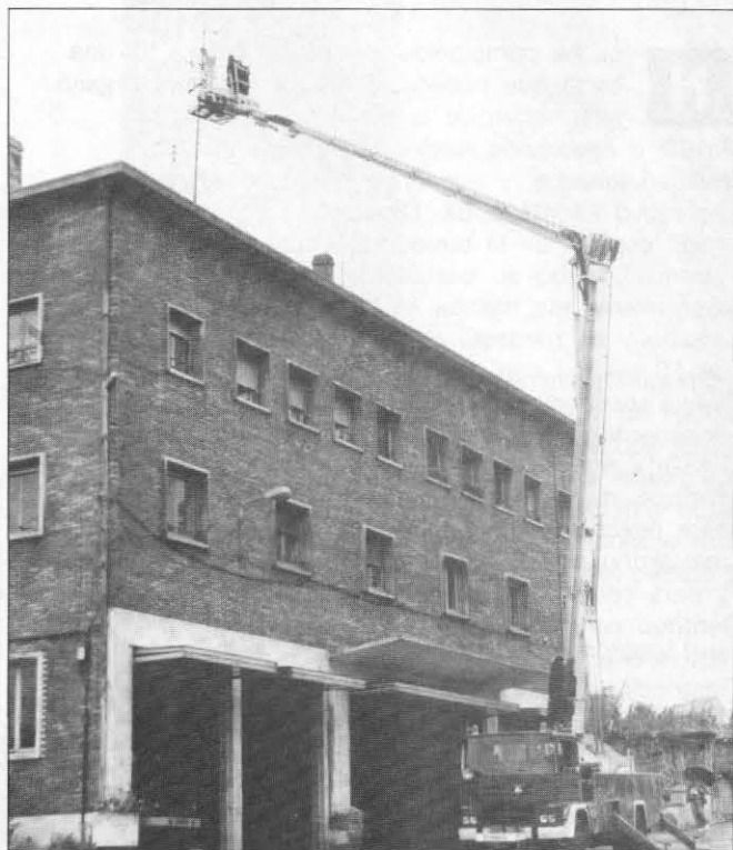
Los que están en la cesta de la grúa son EA1ATQ y EA1ATS. No están luchando contra un voraz incendio, sino colocando una antena de UHF en el parque de bomberos de Santander. Foto EB1DKE.
