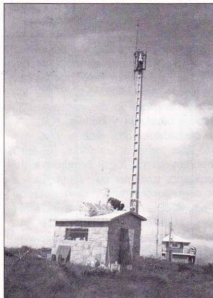
Trabajando en el repetidor de UHF. Julio de 1992. Puede apreciarse la calidad estructural de la caseta de piedra de la zona, detalle de protección de las placas solares y el balconcillo en el alto del poste que facilita el trabajo sin tener que usar el cinturón de seguridad.
