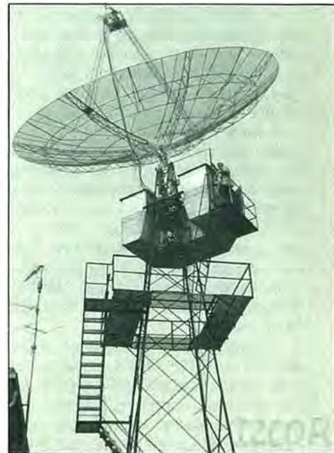
Espectacular instalación de I2COR. Parábola de 10 m de diámetro con cuarto de radio adosado. 432 y 1.296 MHz/EME.
