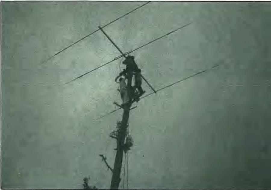
Montaje de la antena direccional AH-15 en la misión de Camerún en plena selva, aprovechando como torre el tronco de un eucalipto de doce metros. Los nativos aprovechan para trepar las ramas del árbol y apoyos metálicos clavados en el tronco, para operar la TJ1GM.
