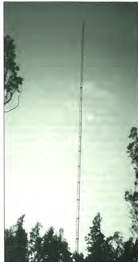
La torre de 57 de CT3FN en el pico da Coroa, 3/4 de onda en 80 metros.
