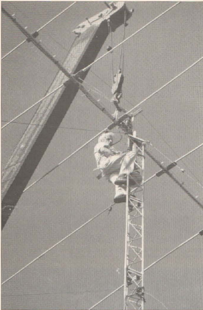
VK9NS dispuesto a unir la gigantesca antena «log periodic» al mástil rotatorio. Imagino que VK9NS debe utilizar un rotor muy poderoso dada la elevada resistencia al viento que debe presentar esta antena.
