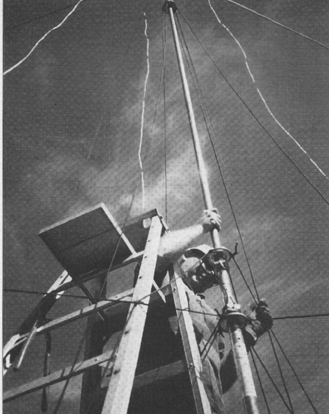
Ed Goodman, uno de los diseñadores de la antena Uni-Hat levantando el tubo telescópico de tres secciones que sirve de soporte a la antena y que va puesto a tierra.
