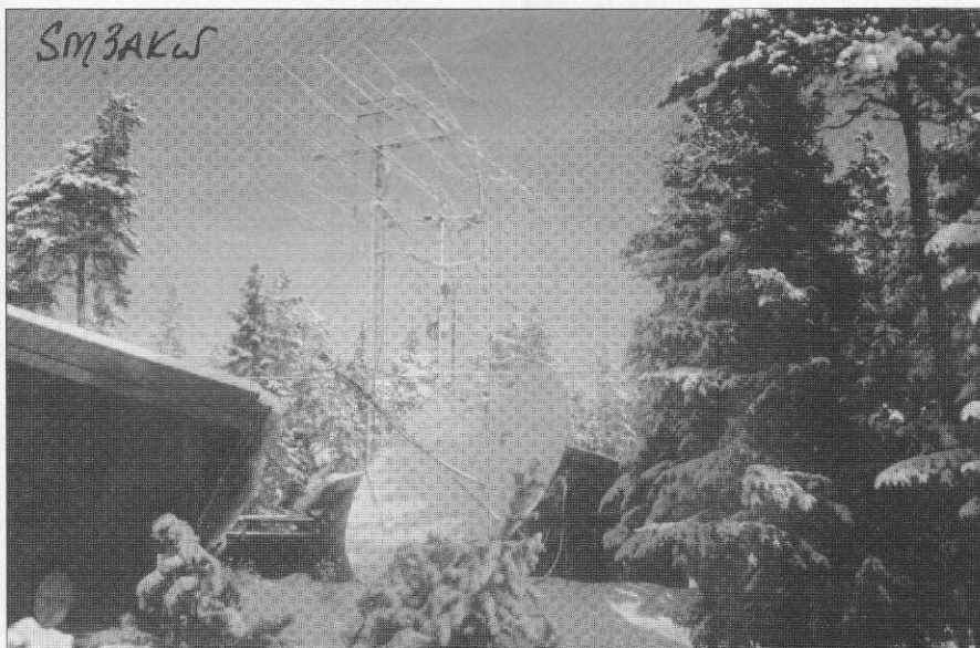
Obsérvese el montaje opuesto de las antenas para 2 metros respecto de la formación de 432 MHz para evitar la interacción de ambos sistemas (SM3AKW).
