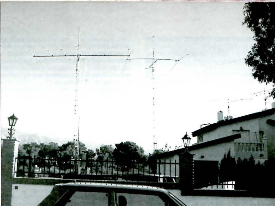
Una instalación de antenas eficaz: EA3KU, en L'Ametlla de Mar. A la izquierda: una KLM 34X. Centro: KLM monobanda. A la derecha: Yagi 17 el. para 2 metros.
