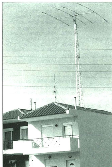
Chris, SV2CWY, ha encontrado la solución para la falta de espacio donde levantar antenas. Su torreta casera, con una Mosley TA53M se extiende a través del tejado de su casa.
