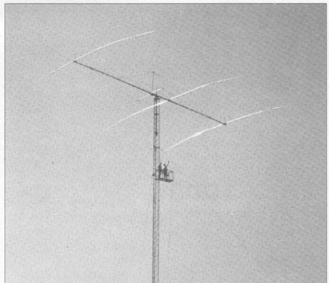
Se puede juzgar el tamaño del conjunto por la dimensión de los hombros sobre la plataforma. Ésta se pliega contra la torre cuando no está en uso.
